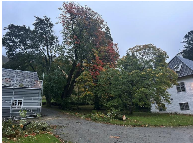
Uvêret «Amy» gjorde stor skade på båt- og vognhuset.
